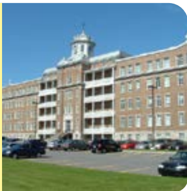
Centre administratif du Centre intégré universitaire de santé et de services sociaux de la Capitale-Nationale (CIUSSSCN).
