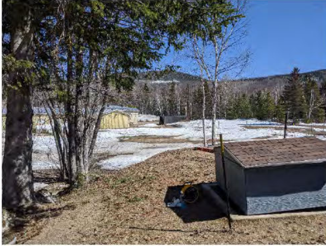
Photo 1 : Bâtiment abritant le puits P-284
