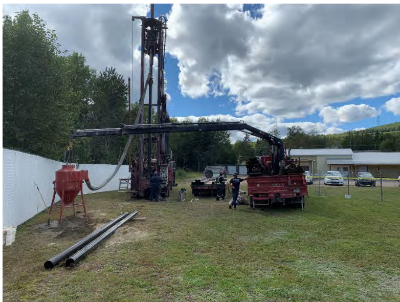
Photo 9 : Forage du puits P-4
